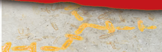
Schneeketten beschädigen den Hallenboden.
